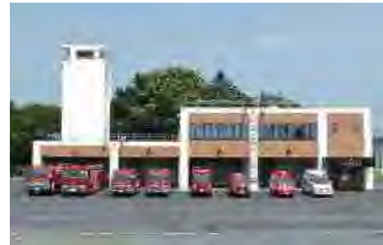
中川消防支署新庁舎
