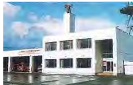
音威子府消防庁舎
